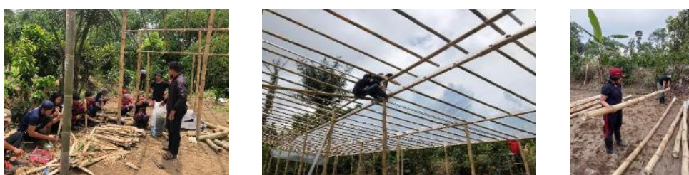
Gambar 3. Pembuatan Greenhouse Bunga Mawar Desa Pengotan
