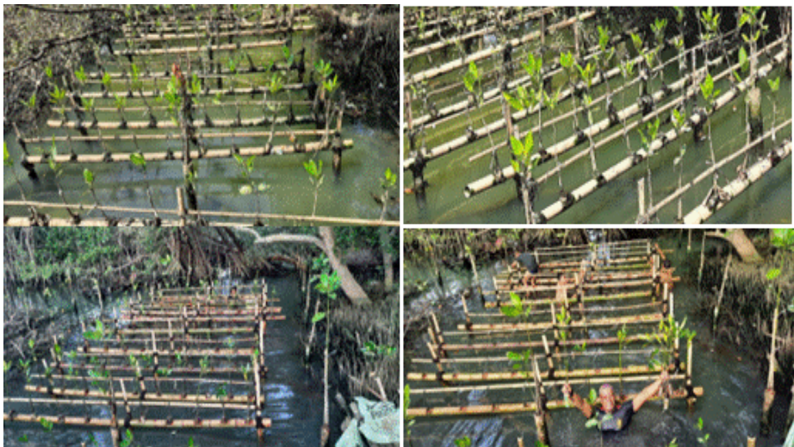
Gambar 11 Peletakan Bambu Tempat Bibit Mangrove
