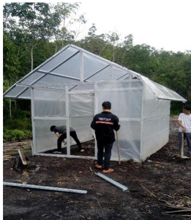
Gambar 3. Proses Pembuatan Greenhouse
